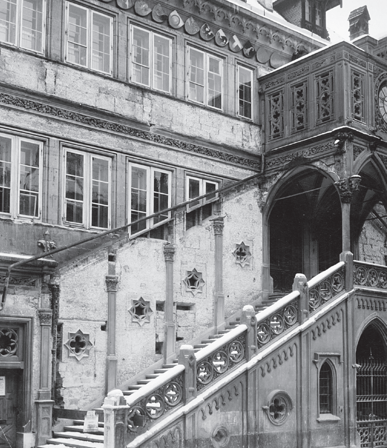
Umbau Rathaus 1940–1942: Westliche Hälfte der Rathaus-Fassade nach dem Abbruch des Daches über der Rathauptreppe. Die Masswerkbrüstung der Treppe, die Wandverkleidungen oder auch der Uhrenkasten stammen vom neugotischen Umbau, der Wappenfries mit Baldachin und die Gewölbe des Vorbaus dagegen sind alt und werden erhalten bleiben. – StAB, BB 05.7.846, Nr. 100. Foto: Hans Steiner, Dezember 1940.
