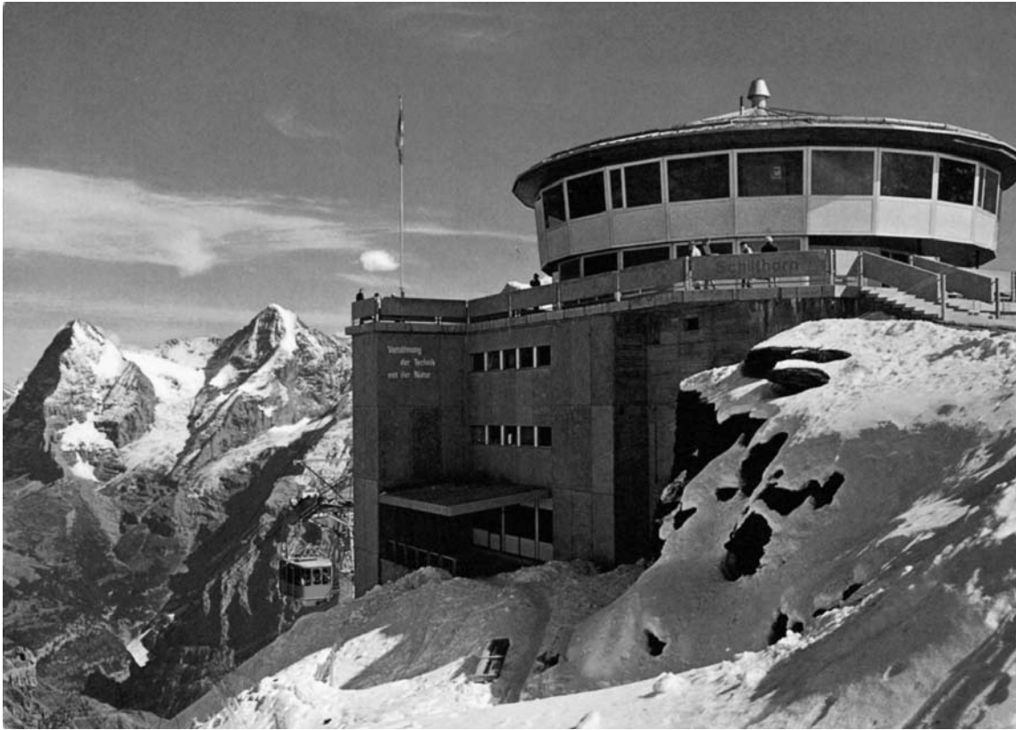
Abb. 7 Fertige Gebäudehülle auf einer ersten Ansichtskarte. Das oberste Geschoss der Gipfelstation stand nach der Eröffnung noch leer. Die Bauseilbahn im Vordergrund musste aus dem Bild wegretouchiert werden. Ansichtskarte, Colorphoto H. Steinbauer, Interlaken, Nr. 7688, gelaufen (ohne Datum, Briefmarke wurde abgelöst). – Sammlung Daniel Bernet, Bern.
